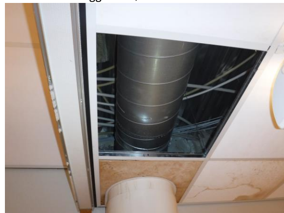
Bilde 7: Lekkasje tak (1994-del mot øst).
