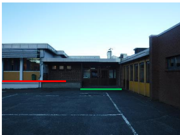
Bilde 8: Nivåforskjell mellom byggetrinn i Bygg A
