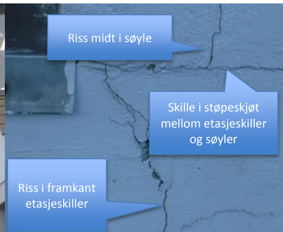
Bilde 5: Riss i vegg mot sør
