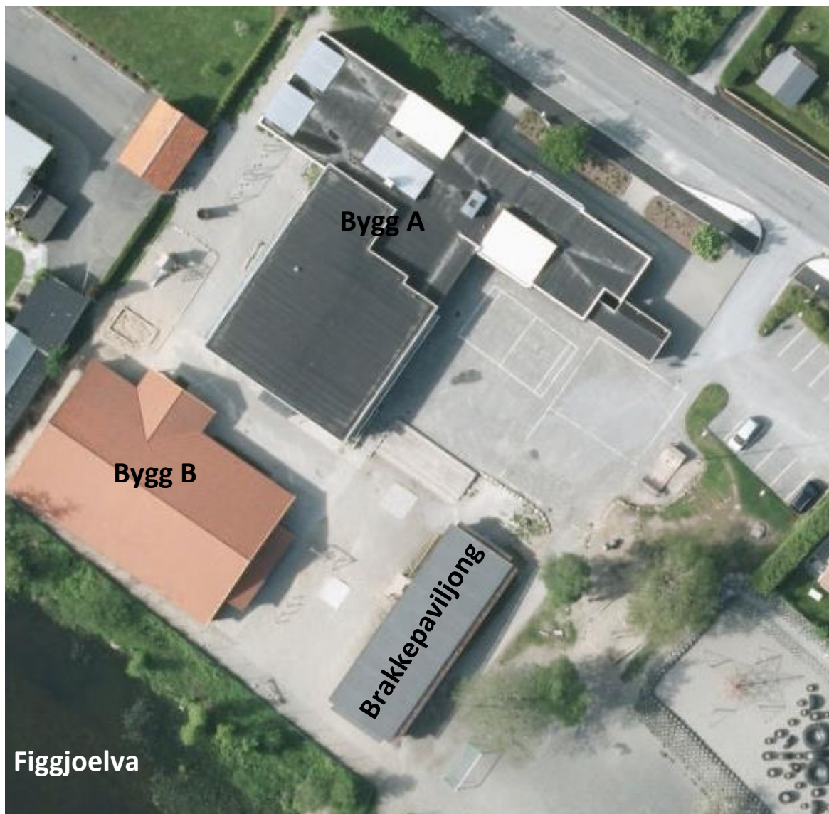
Bilde 1 Figgjo skole, Figgjenveien 31-33. Kilde: Norge i bilder
