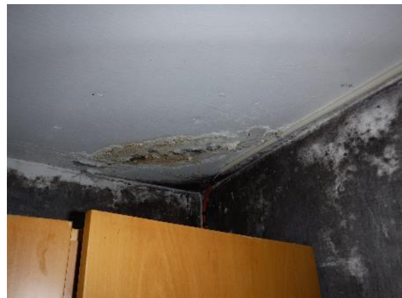
Bilde 3: Vanninntrenging i himling
