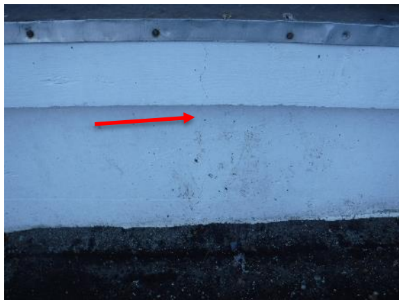
Bilde 2: Riss i tilfluksromvegger
