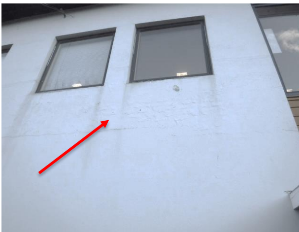
Bilde 4: Buler i maling, fasade mot vest
